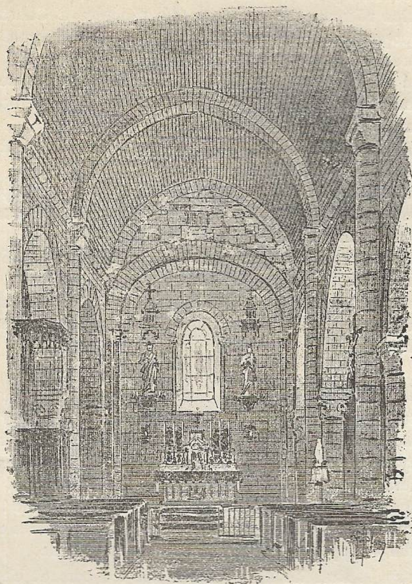
Eglise Paroissiale (Chœur).
